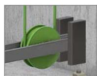
Dispositif tendeur du limiteur de vitesse
