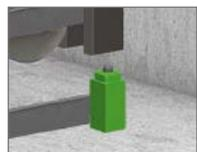
Schalter für Schlaufseilüberwachung (Begrenzerseil)
