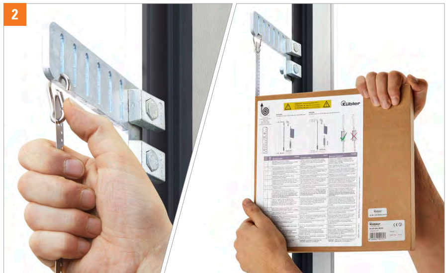
2 Codeband mittels Karabiner im Langloch der Schienenbefestigung einhängen. Seitenausrichtung der Codeband-Löcher, Abbildung auf dem Typenschild des Sensors und Installationsanleitung auf der Codebandverpackung (6-sprachig) beachten. Codeband wird während der Abwärtsfahrt aus der Kartonverpackung ausgerollt.
